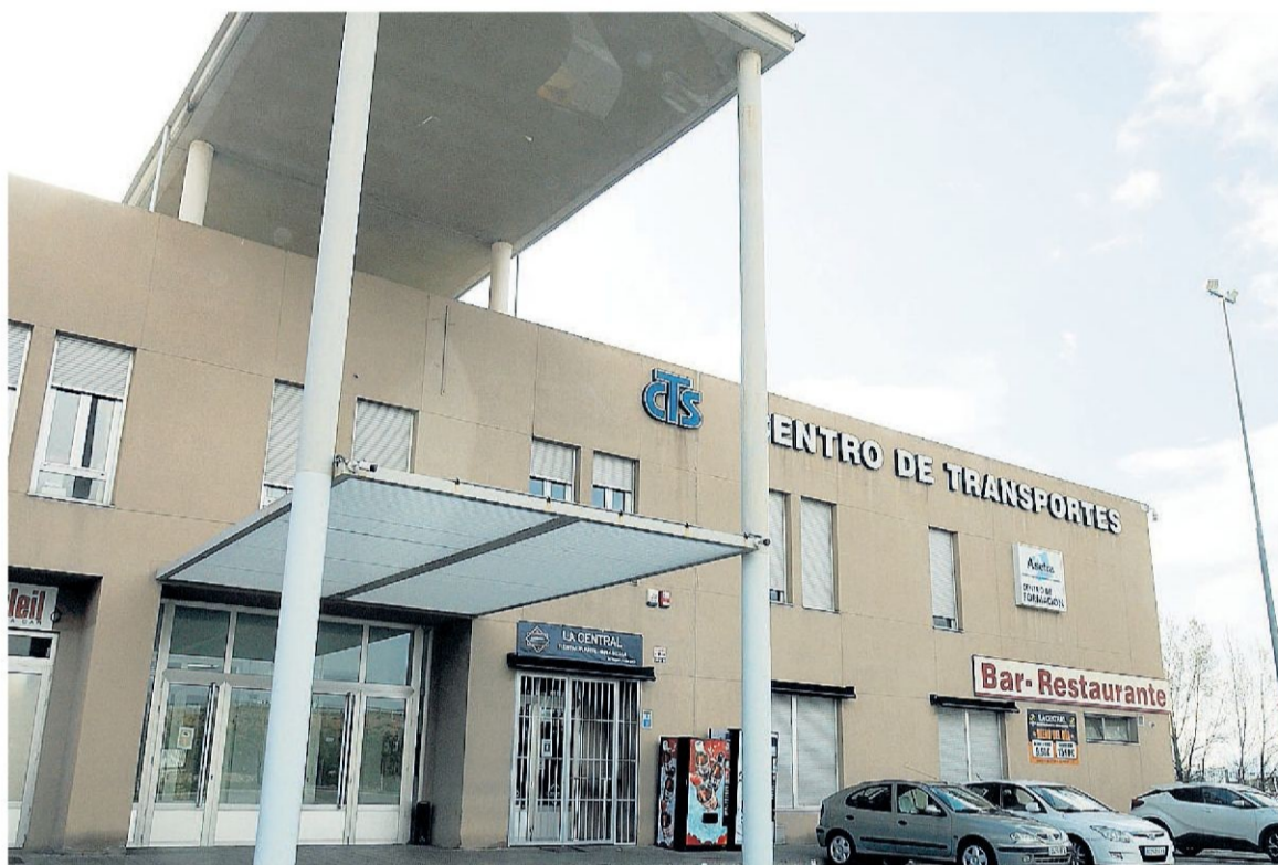
El Centro de Transportes mantiene cerradas al público sus instalaciones.
