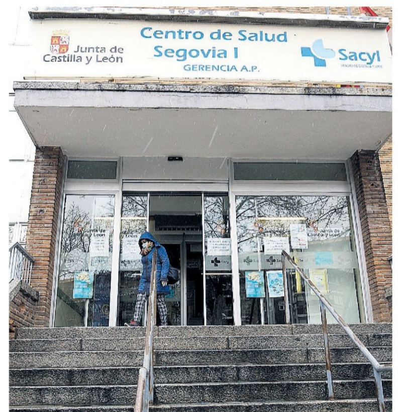
Acceso al centro de salud ubicado en Santo Tomás.
