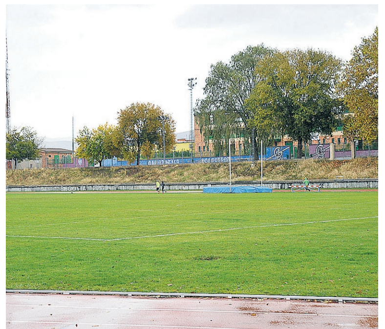
Vista parcial de la zona donde irá ubicado el módulo cubierto.
