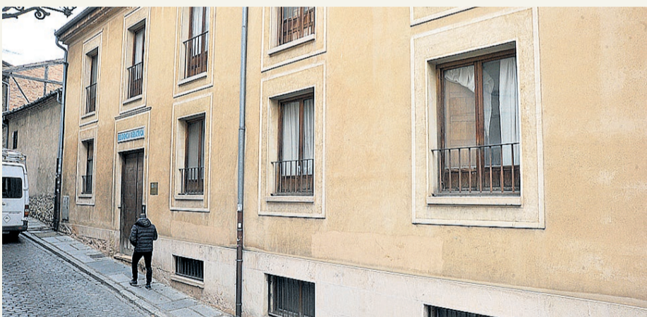
RESIDENCIA EN DOCTOR VELASCO (IE). Gestionada directamente por la IE para sus estudiantes, su apertura está prevista el próximo curso. Contará con cinco pisos, 63 habitaciones individuales y todo tipo de comodidades.
