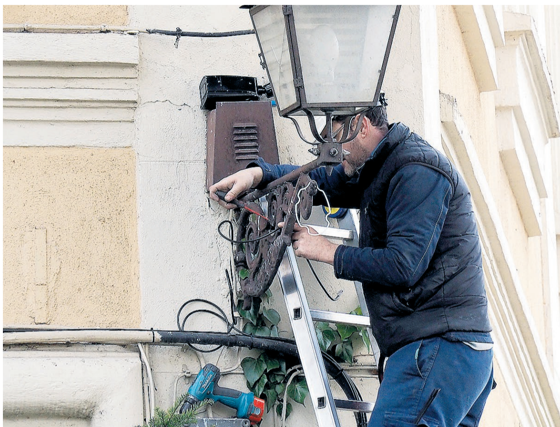
Un operario instala uno de los sistemas de vigilancia en la mañana de este viernes.
