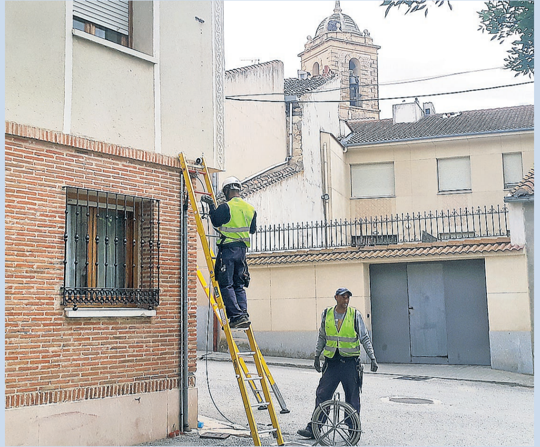
Dos operarios instalando fibra óptica en la localidad segoviana de Valseca.
