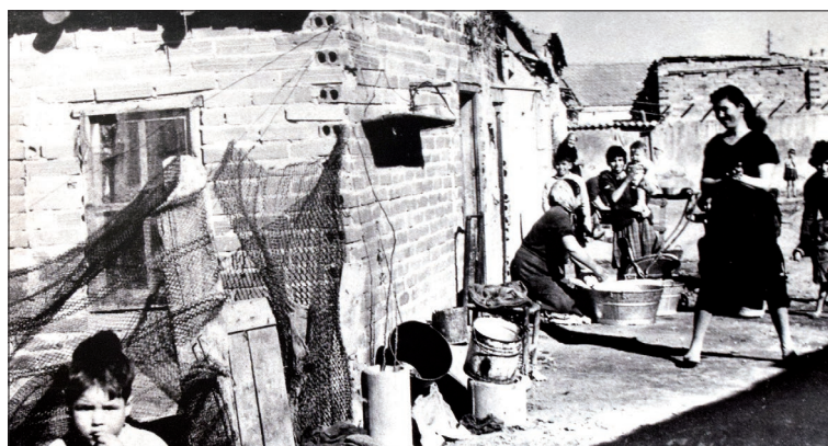
Infraviviendas en el Barrio España, Valladolid, hacia 1965. / ARCHIVO HISTÓRICO PROVINCIAL
