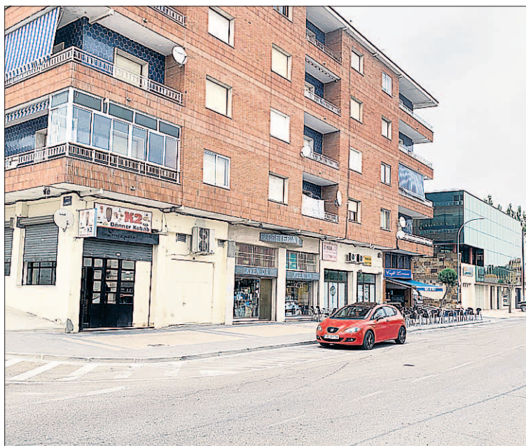
El estacionamiento se prohibirá en toda la margen de acera de este tramo. / C.N
