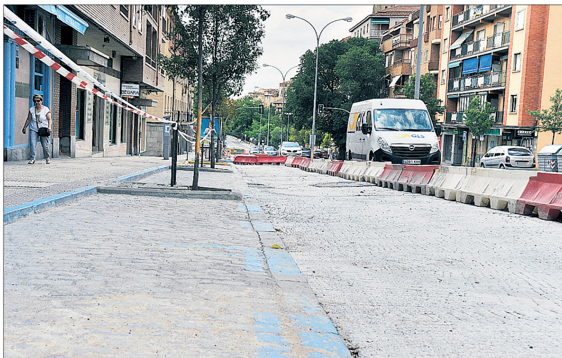
Estado actual del primer tramo de la calle Ezequiel González. / KAMARERO
