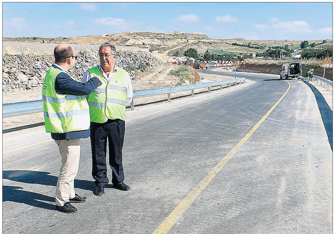
Imagen de un tramo cortado con motivo de los trabajos de la SG-20. / EL ADELANTADO
