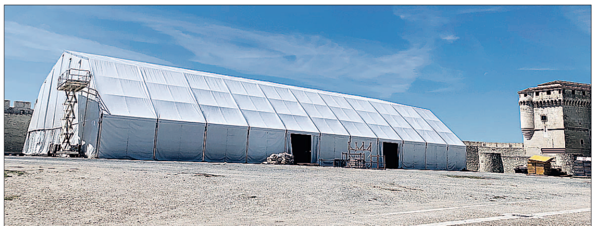
Avances en la trabajo de instalación de la infraestructura de carpas de la Feria de Cuéllar. / C. NÚÑEZ
