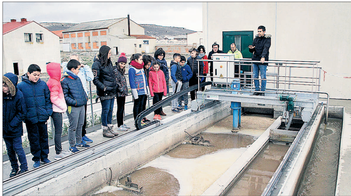
Visita a la EDAR del resto de centros escolares de la villa el año pasado. / C. NÚÑEZ
