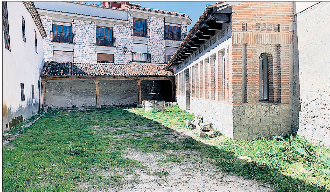
El suelo del patio de la cárcel vieja se cubrirá de hormigón impreso para el futuro centro arqueológico./C. NÚÑEZ
