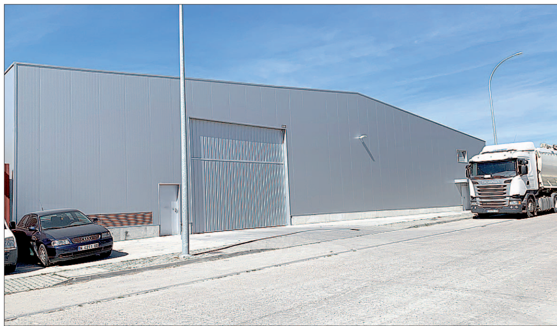
Nave de servicios municipales de Malriega, cuyo forjado comenzará a realizarse en breve. / C. NÚÑEZ
