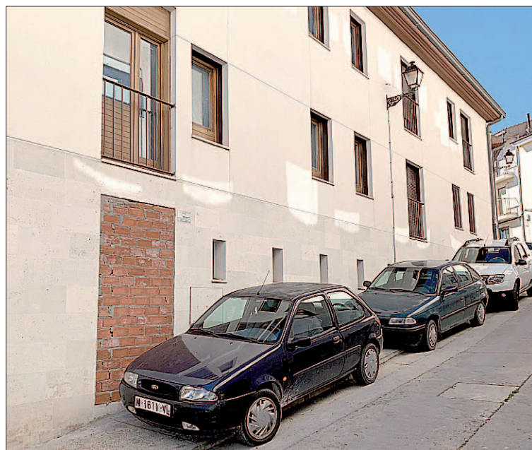
Tras la última ocupación, se han tapiado los accesos a las viviendas. / C. NÚÑEZ
