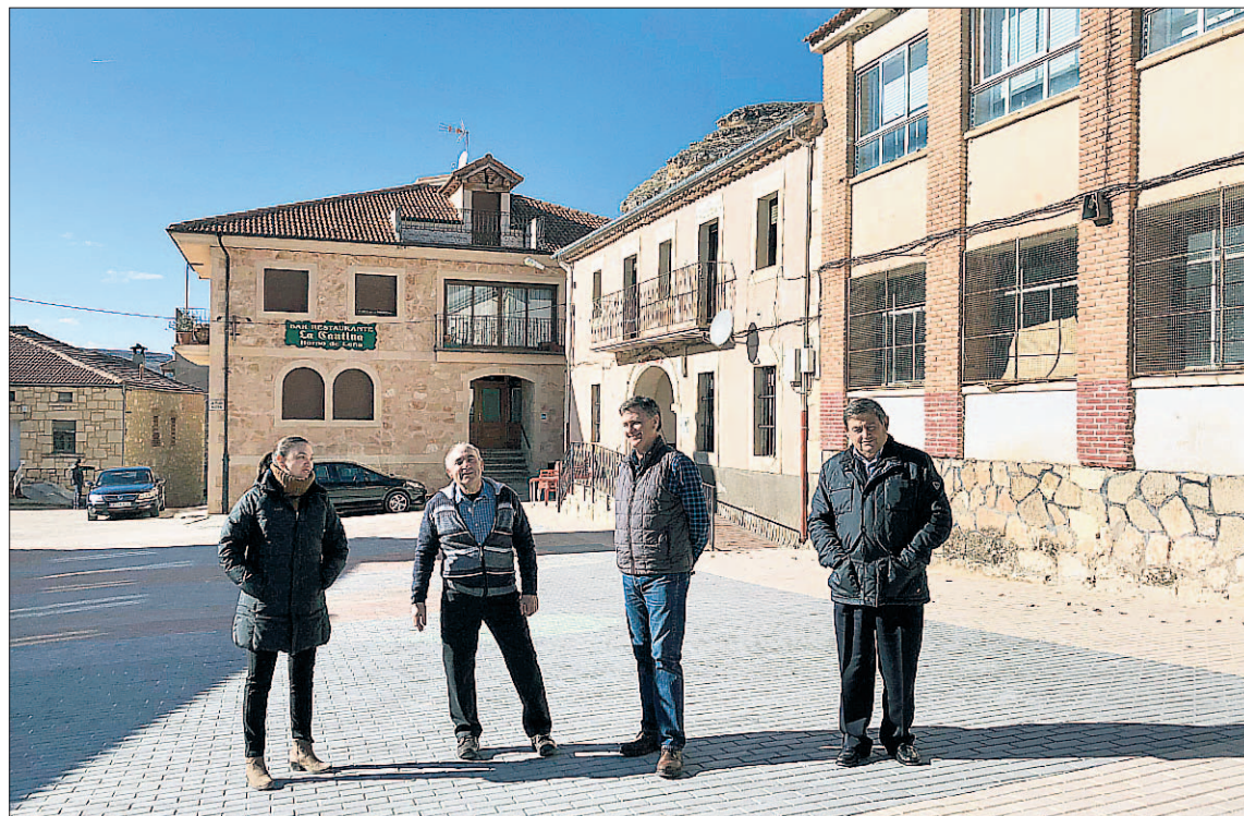
La remodelación consistió, entre otras cosas, en la colocación del nuevo pavimento adoquinado de diferentes colores. / E. A.
