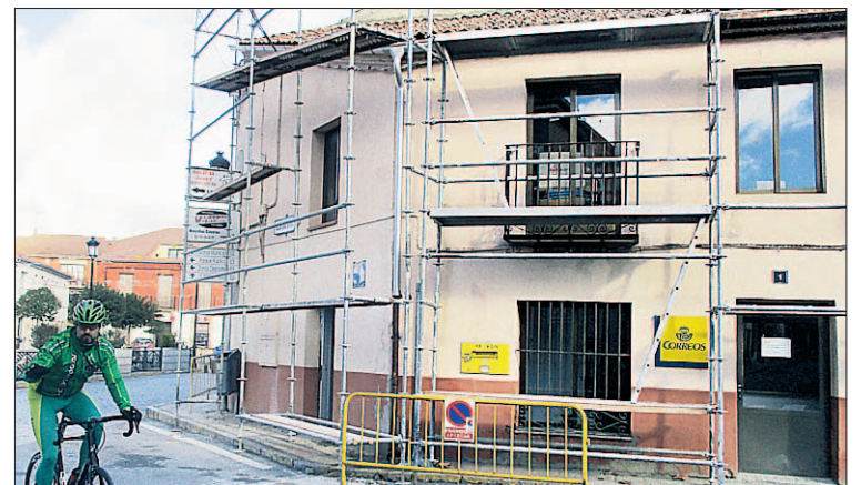
Una de las actuaciones que se está ejecutando. / L.M.
