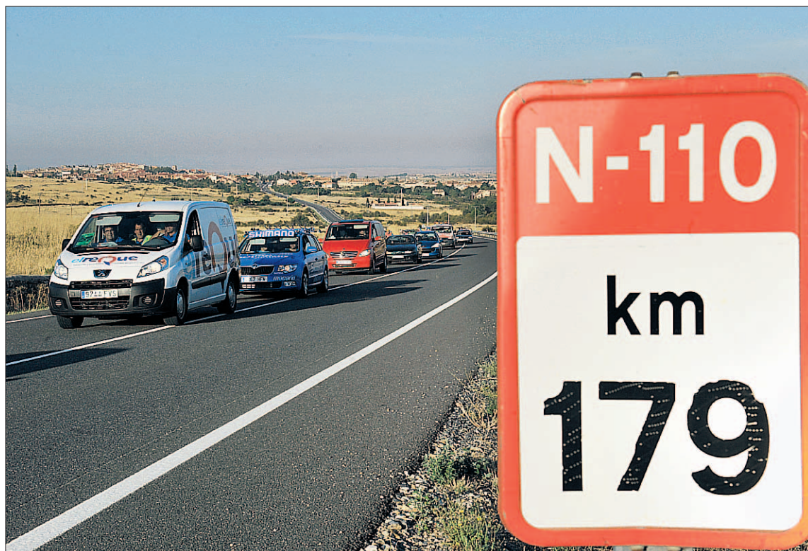
La carretera N-110, a su paso por Segovia, también se verá afectada por la nueva norma. / KAMARERO
