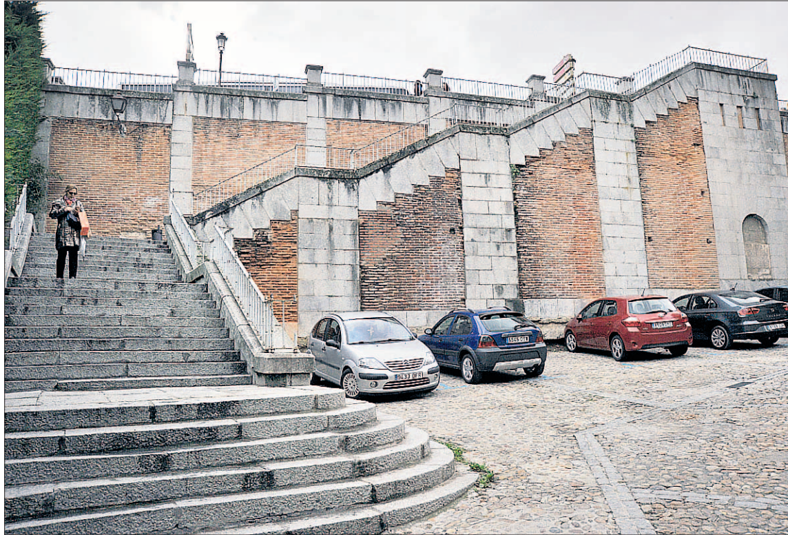
Escaleras de acceso a Vía Roma, en la calle Gascos, que comunica el centro con el barrio de San Lorenzo. / KAMARERO
