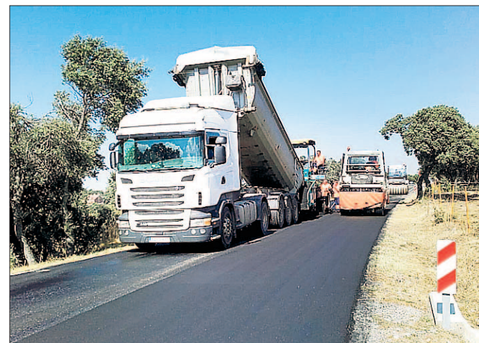
En los próximos días concluirán las obras. / EL ADELANTADO
