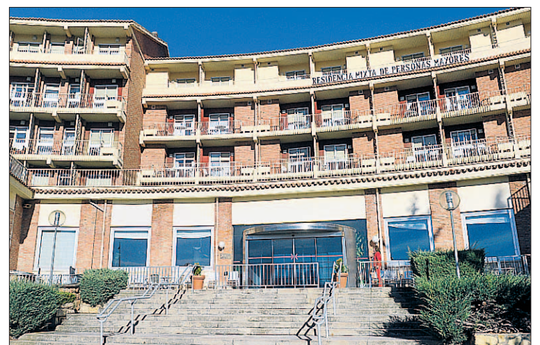
Fachada de la Residencia Mixta de Personas Mayores. / KAMARERO
