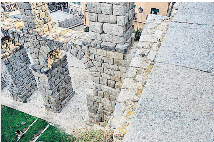
La zona en la que Murray llevó a cabo la limpieza está en el Postigo. / KAMARERO
