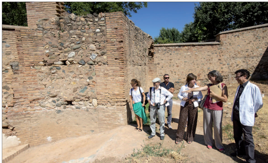
Instantánea de la restauración del muro de la Huerta Grande del Generalife (Granada). / EUROPA PRESS
