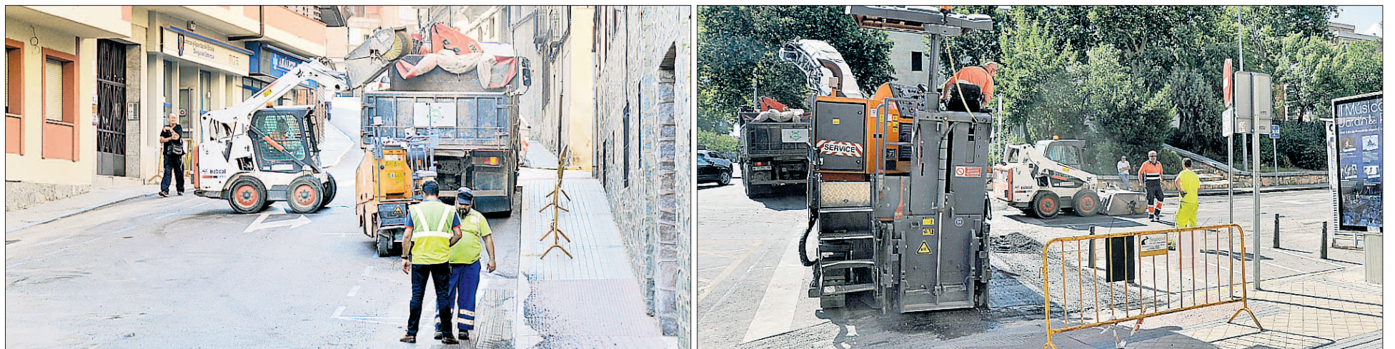
Los trabajos de reparación de deficiencias comenzaron ayer en la zona baja de la calle Antonio Machado y en la entrada a la Estación de Autobuses. / FOTOS: KAMARERO
