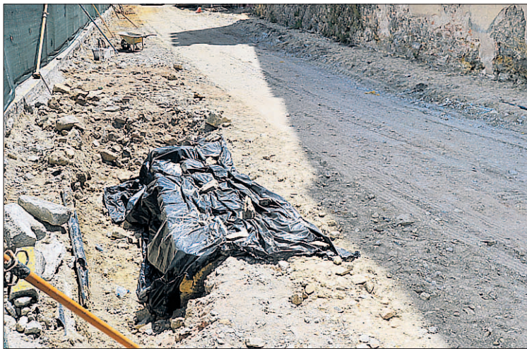
La empresa que ejecuta las obras ha protegido así la zona en estudio. / KAMARERO
