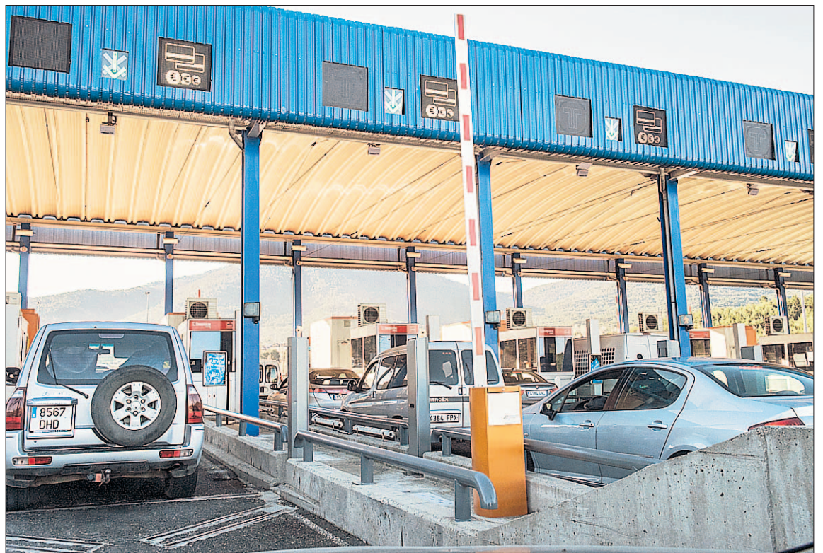
Peaje de San Rafael, en la provincia de Segovia, de la autopista AP-6 (Villalba-Adanero). / KAMARERO
