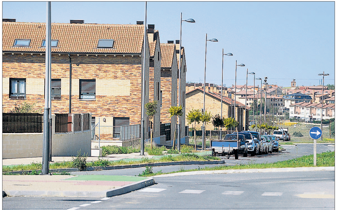
Uno de los accesos al barrio de Carrascalejo, junto a la carretera de La Granja. / KAMARERO
