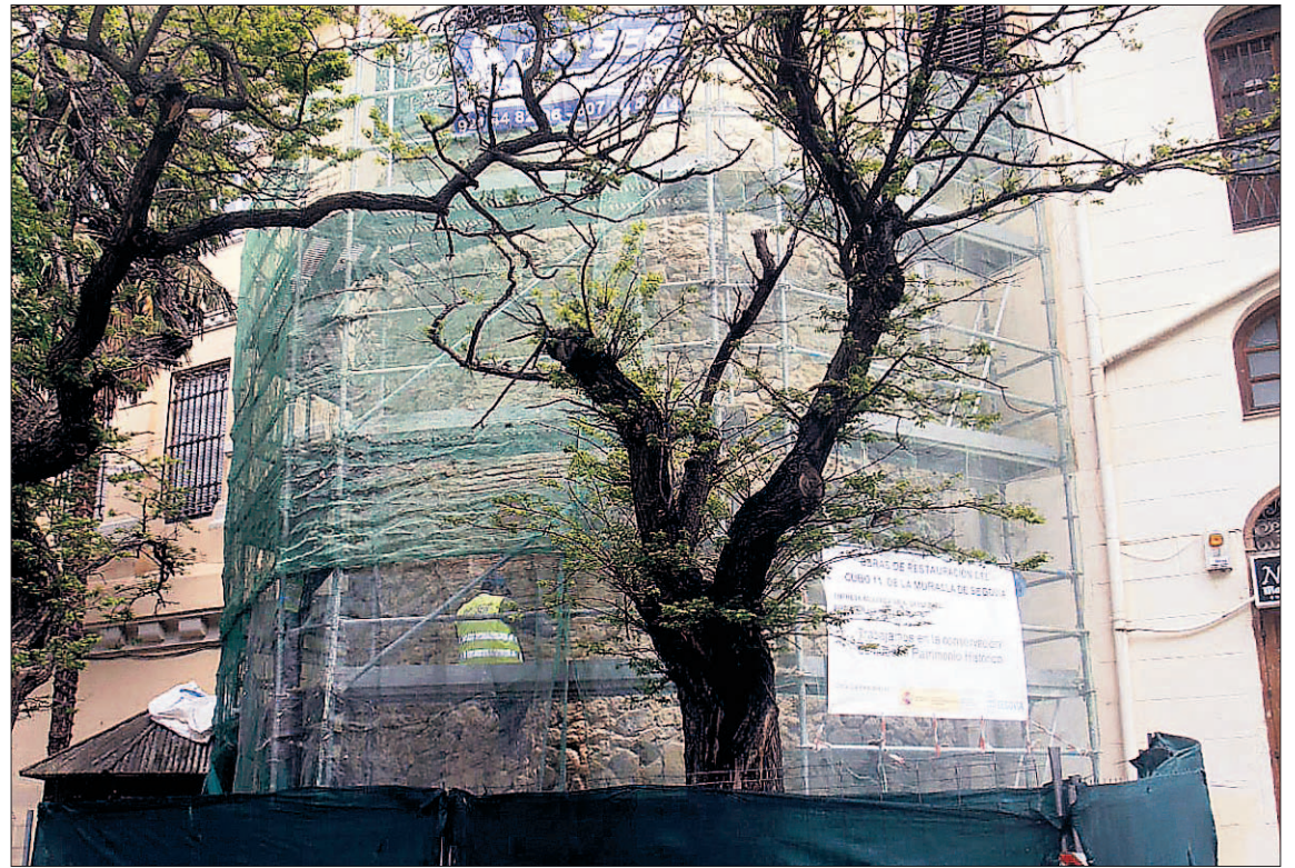
Los andamios tapan este cubo de la Muralla de Segovia situado en uno de los parques más céntricos. / E. A.
