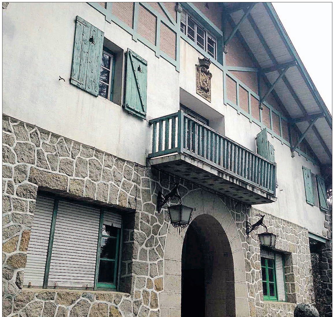
Fachada de la casa forestal 'Cerrillos Hondos', en San Rafael, que se convertirá en Casa del Parque. / EL ADELANTADO
