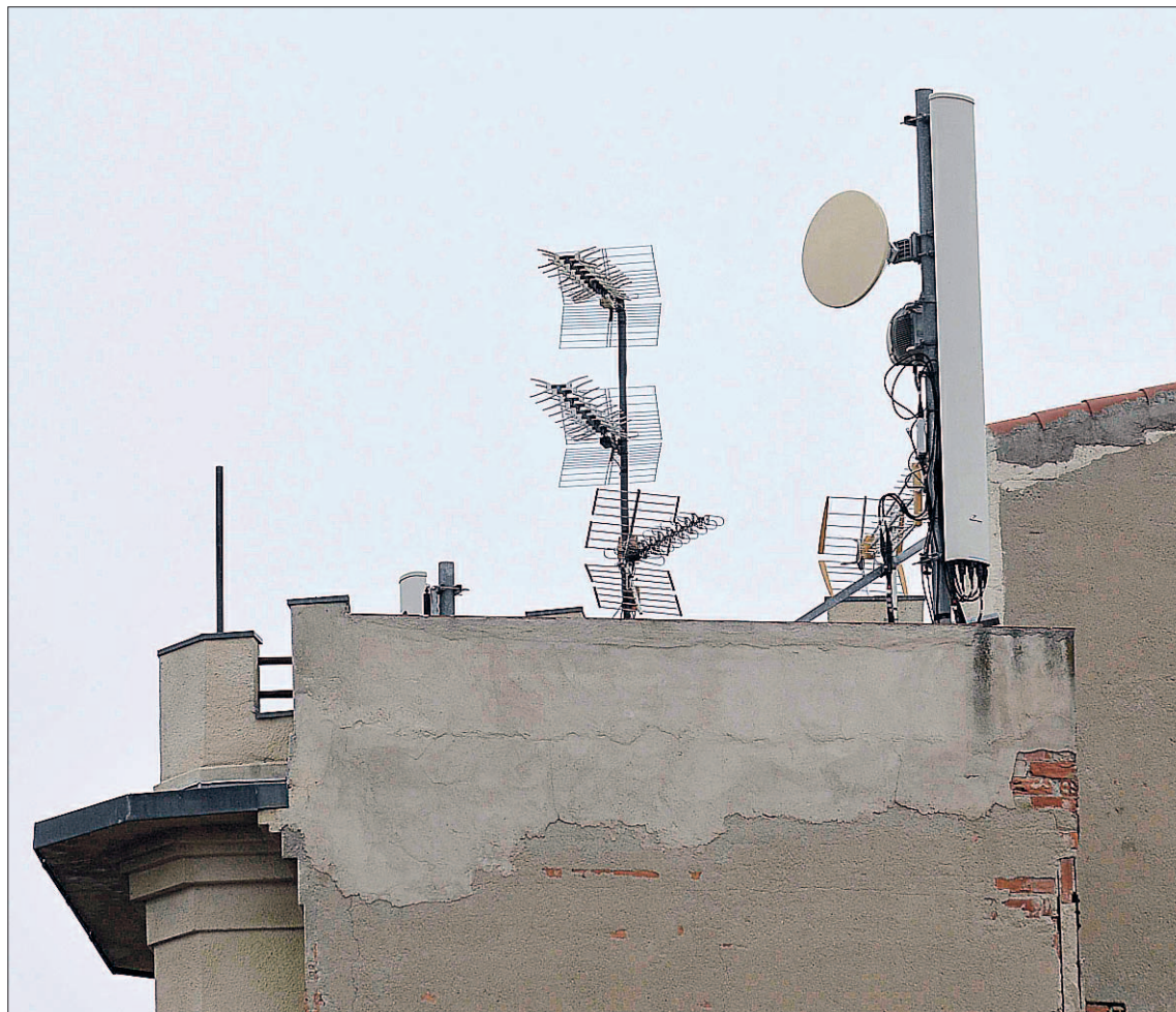
La Diputación quiere mejorar la cobertura con la instalación de nuevos repetidores en la provincia. / KAMARERO
