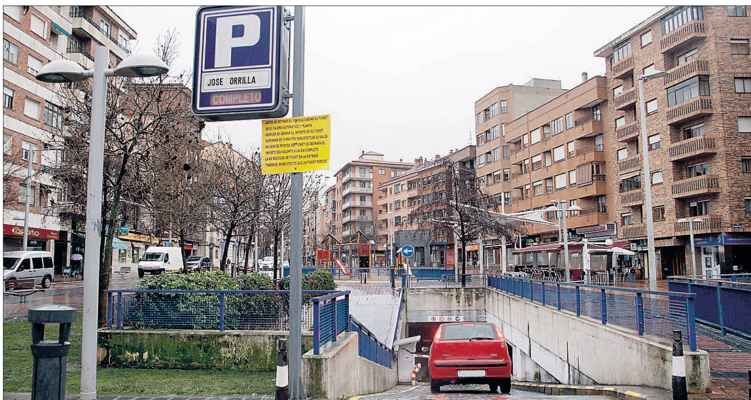
El aparcamiento de José Zorrilla solo presta servicio actualmente a los propietarios de las plazas y a los alquileres de largo plazo. / NEREA LLORENTE
