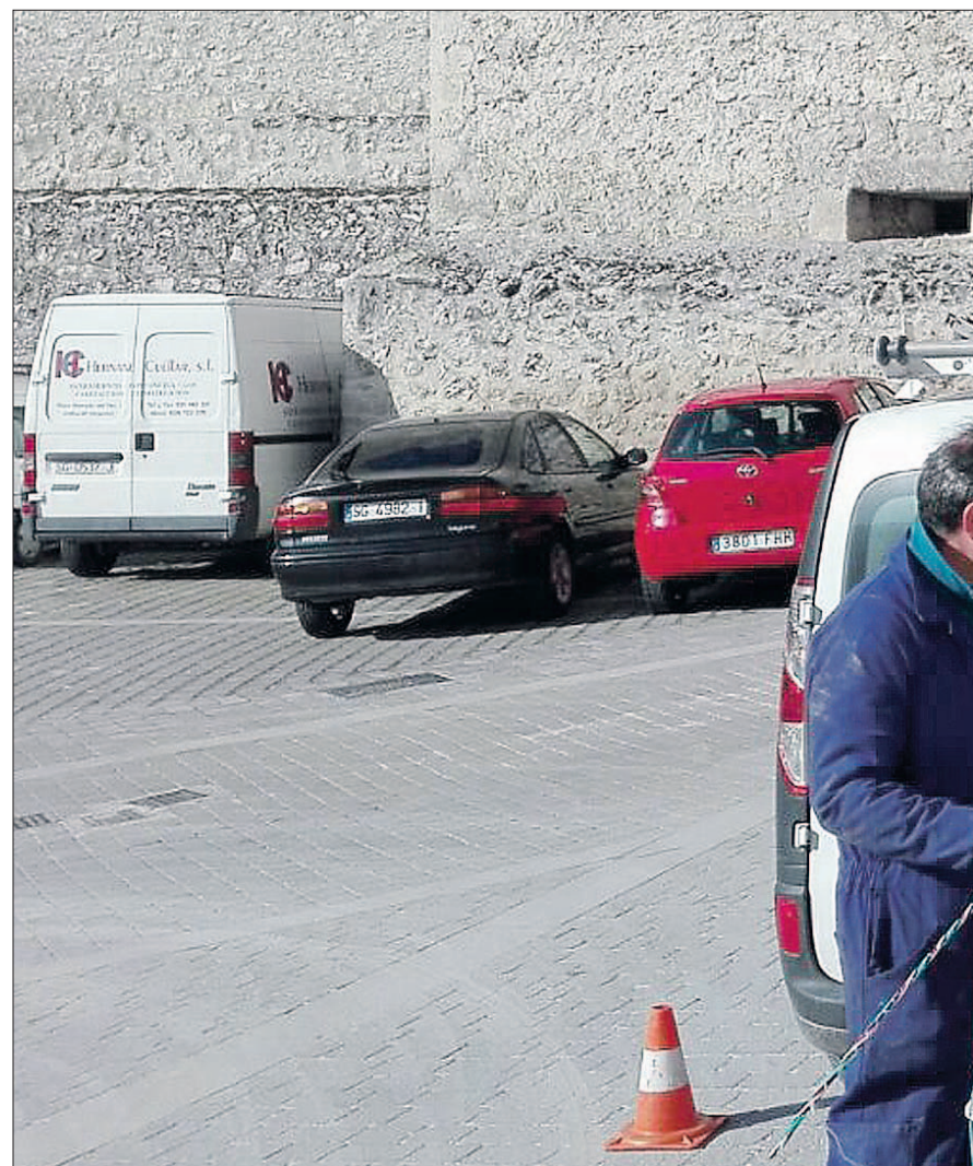
Operarios de telefonía instalando fibra óptica en la localidad segoviana de Cuéllar. La red provin...
