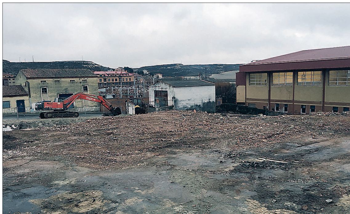
Tareas de demolición del antiguo matadero, situado junto al polideportivo municipal./ C.N.
