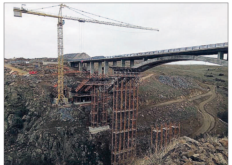
Viaducto en construcción, proyecto incluido en el desdoblamiento de la SG-20. / E.A.
