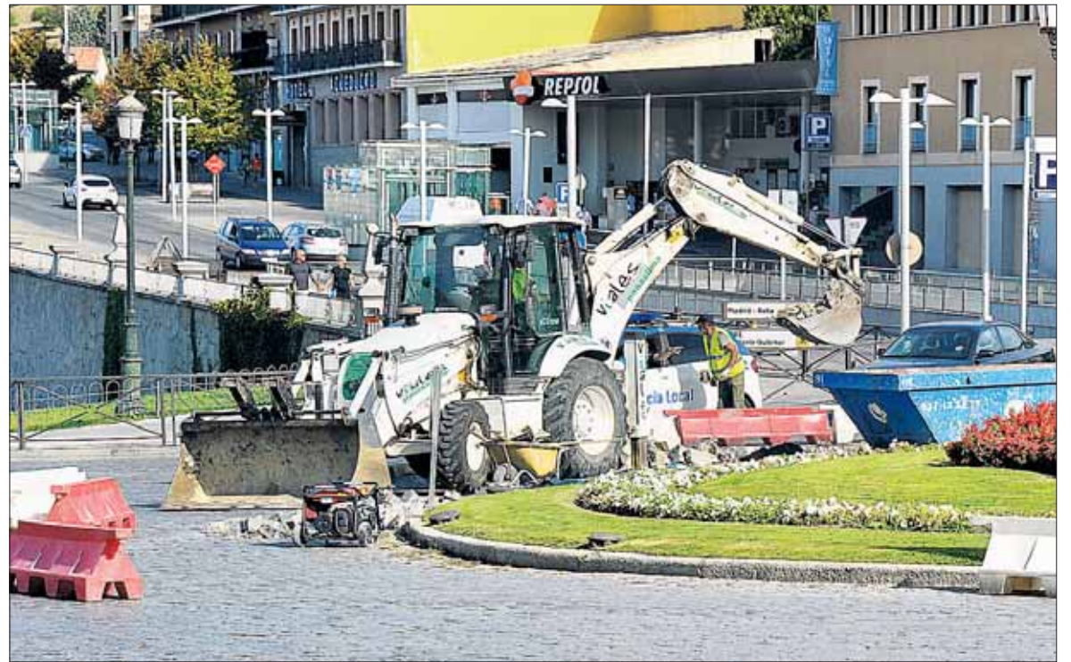
Las obras para reparar el firme en varios puntos con hundimientos del pavimento adoquinado comenzaron el martes. / K.
