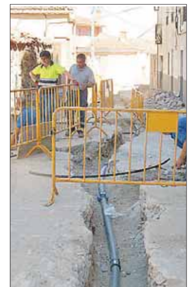
Obras en Hontoria./EL ADELANTADO
