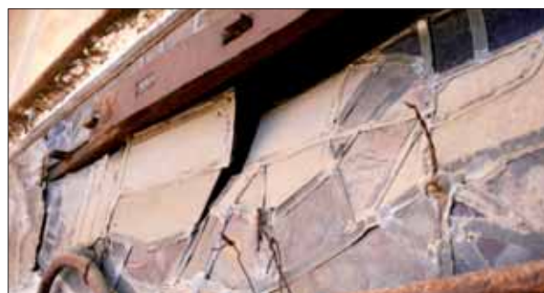
Detalle del estado inicial de una de las vidrieras vista desde el exterior.
