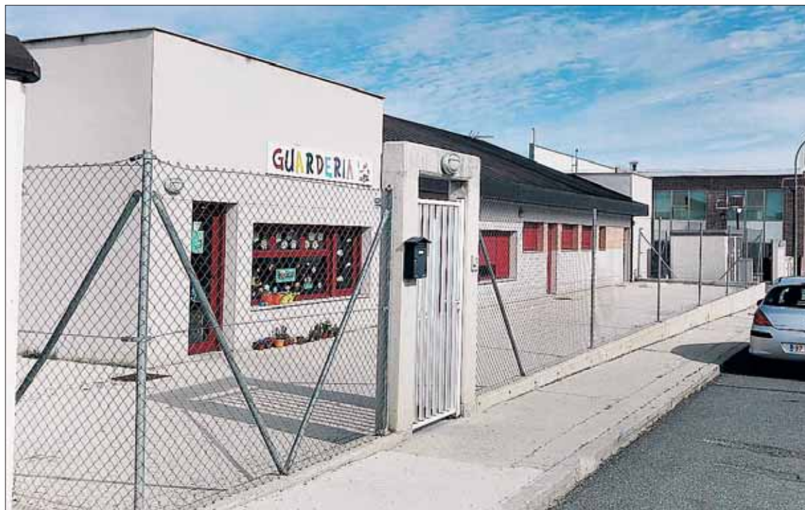
Instalación de la guardería del polígono, que abrió sus puertas en el año 2008. / F.D.
