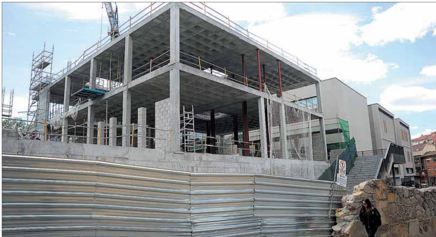
Las estructuras de los edificios de la segunda fase del campus asoman por encima de la valla que delimita el terreno en obras. / KAMARERO
