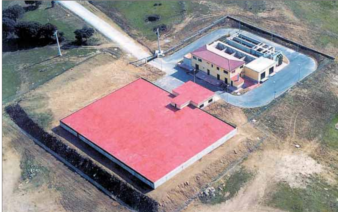
Vista aérea de una de las potabilizadoras del abastecimiento de Segovia, la de Rancho el Feo. / E. A.
