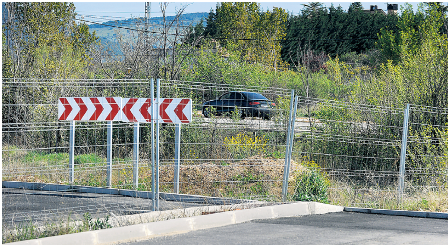
En este punto concluye la Avenida de los Carrascalejos, ya asfaltada y preparada para una futura conexión con la CL-601, al fondo. / KAMARERO
