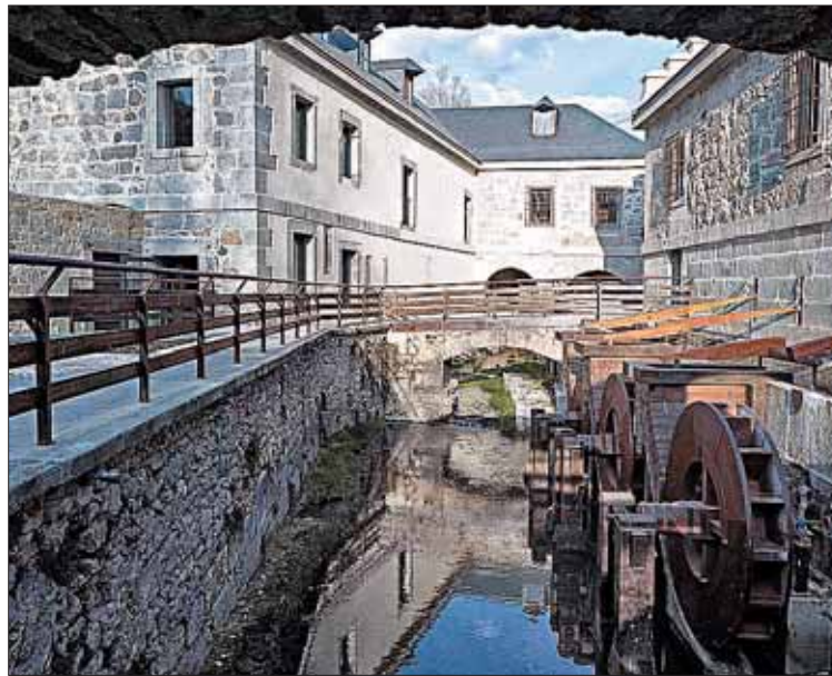
La Casa de la Moneda es susceptible de sufrir nuevas inundaciones. / E. A.
