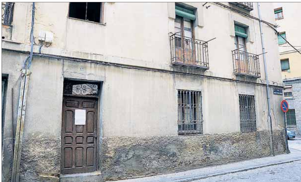
Edificio de tres plantas ocupado por un colectivo que pretende crear en él un centro social autogestionado. / KAMARERO
