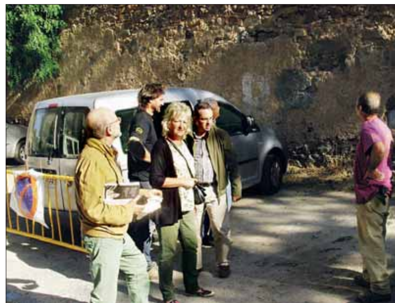
La concejala Paloma Maroto supervisó el inicio de las obras. / E. A.
