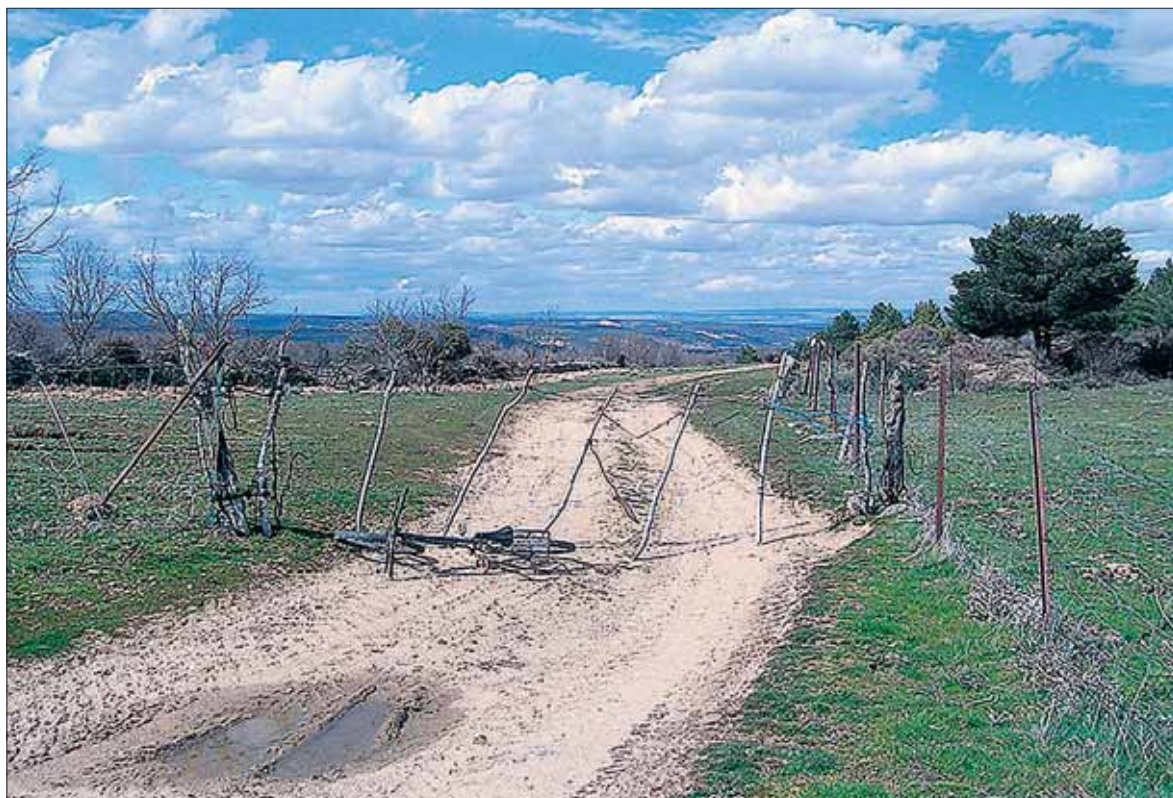
Obras de construcción de un camino rural en la falda de la Sierra de Guadarrama. / EL ADELANTADO
