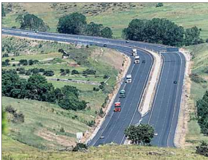
Un tramo de la AP-6 se encuentra en la provincia de Segovia. / KAMARERO
