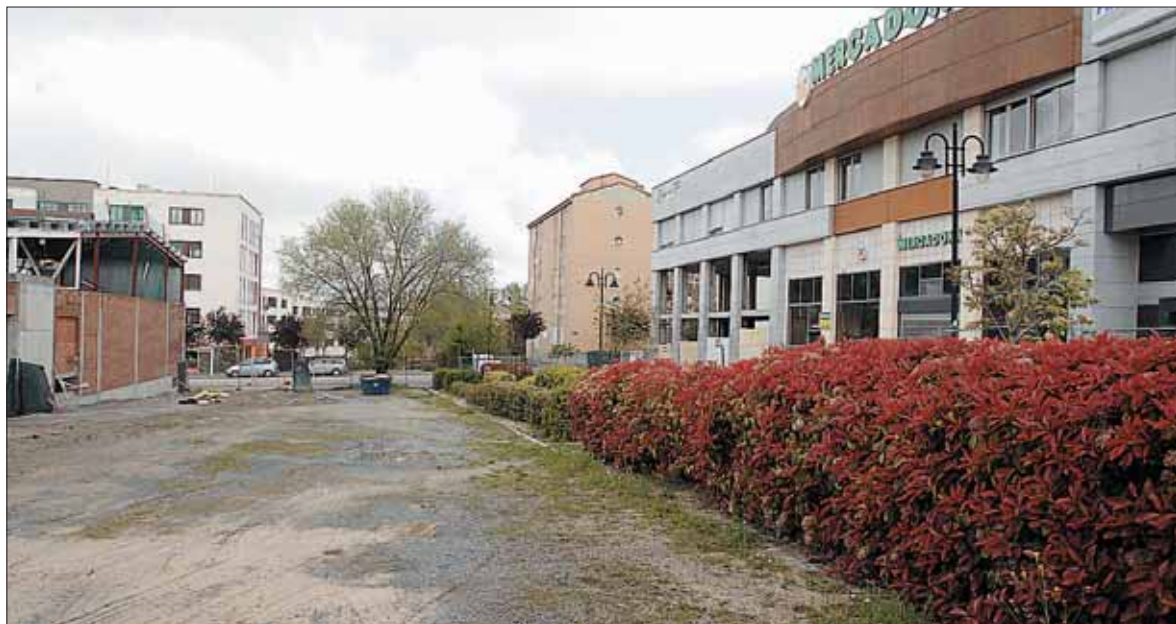
La zona peatonal se encuentra entre el actual Mercadona y el establecimiento de la misma cadena en construcción. / J. MARTÍN
