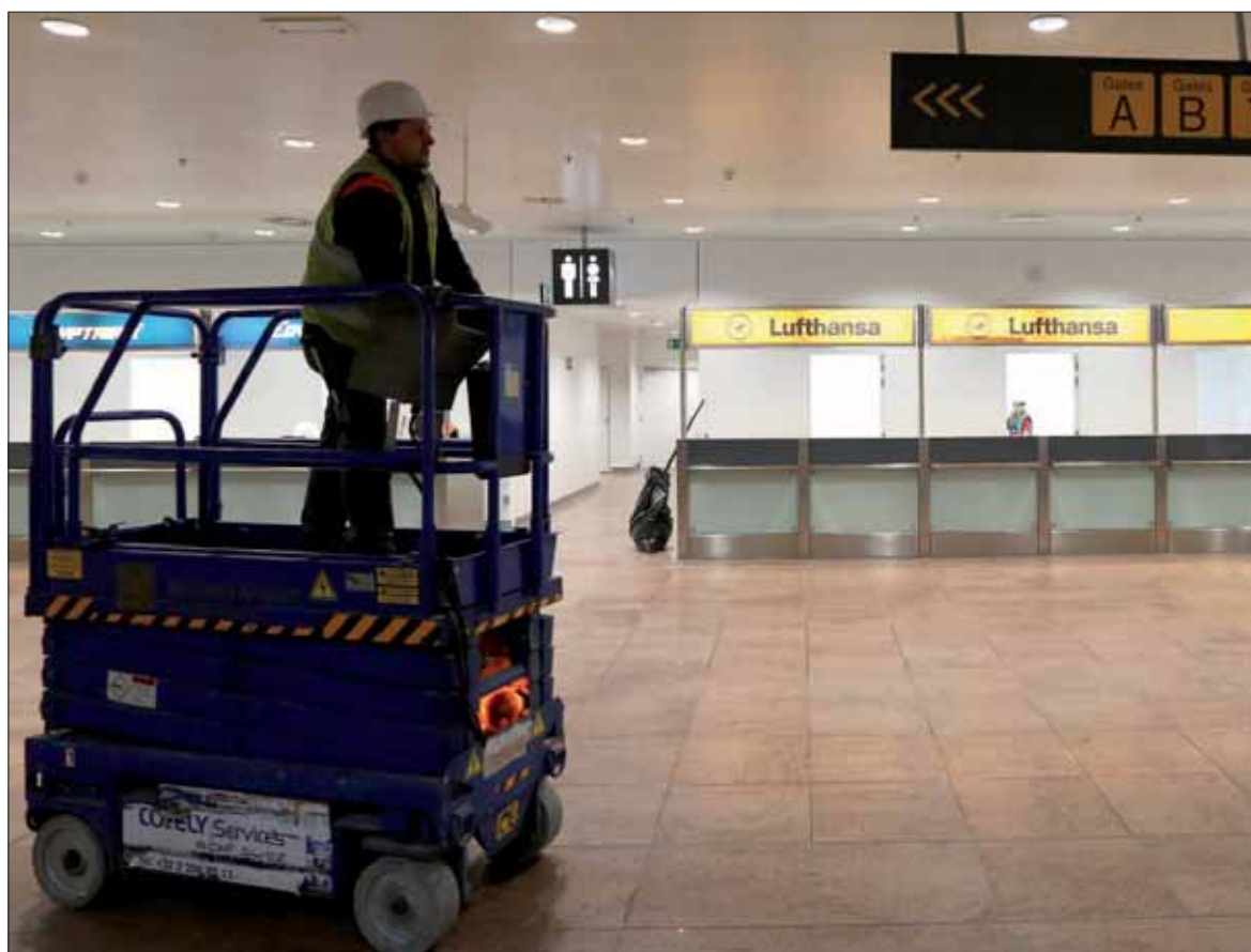
Una imagen de un operario que trabaja en las labores de reparación del aeropuerto de Bruselas-Zaventem. / EFE
