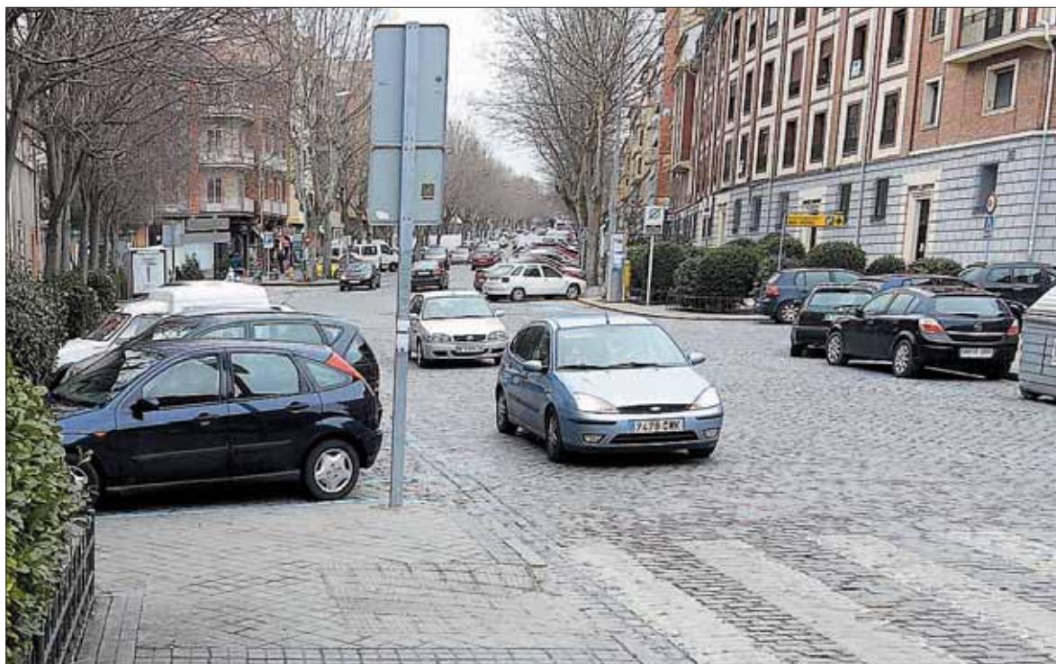
La primera fase de remodelación consistirá en pavimentar la calzada y renovar redes y servicios. / KAMARERO
