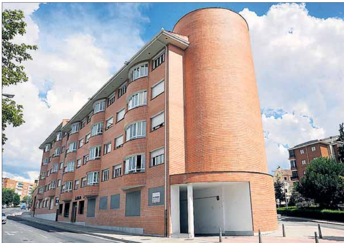
Viviendas municipales en la calle de los Bomberos, conocidas como edificio Evisego. / KAMARERO
