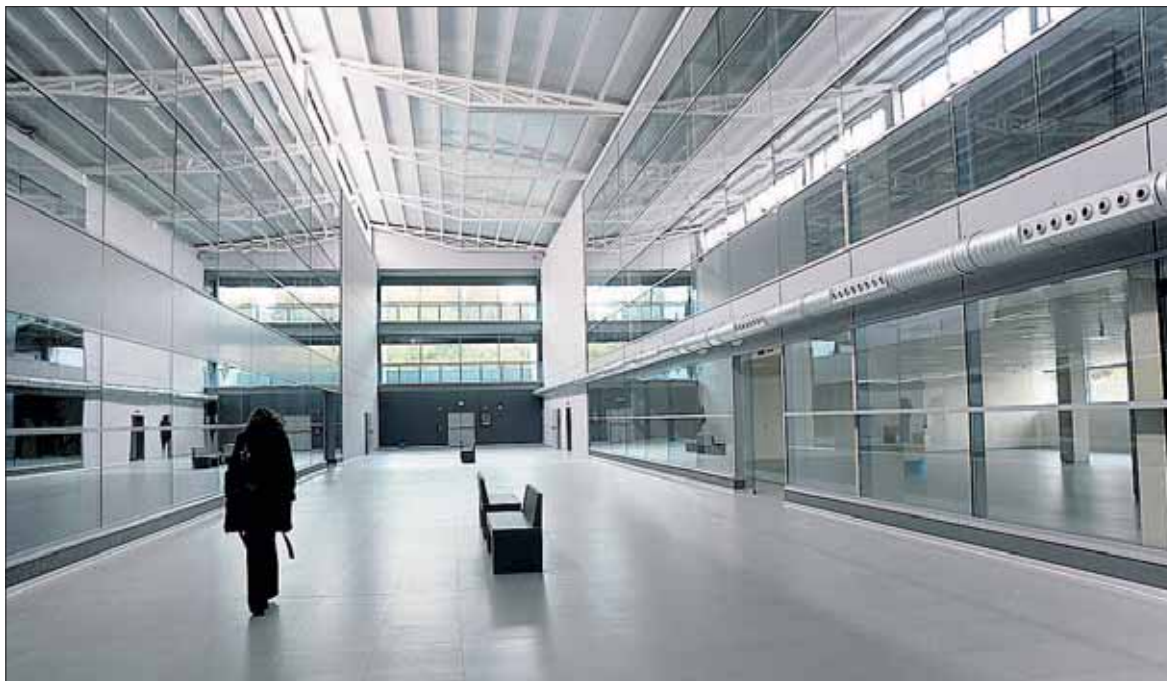
Interior del edificio que acogerá las oficinas del INSS y de la Tesorería en Segovia. / KAMARERO
