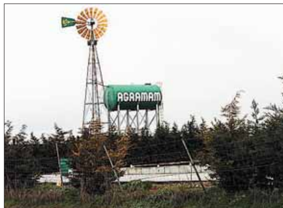
Instalaciones de la planta de compostaje. / G.H.
