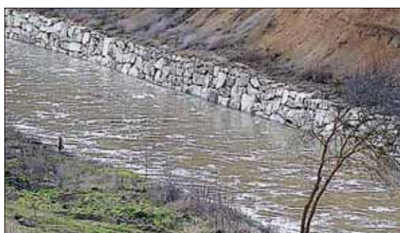
El PP defiende que la CHD realizó correctamente las obras en el tramo A (en la imagen). / EL ADELANTADO
