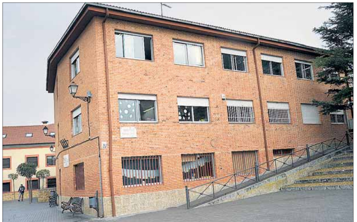
El actual colegio está enclavado en la plaza de Valverde, y los niños utilizan los espacios públicos para su recreo. / KAMARERO
