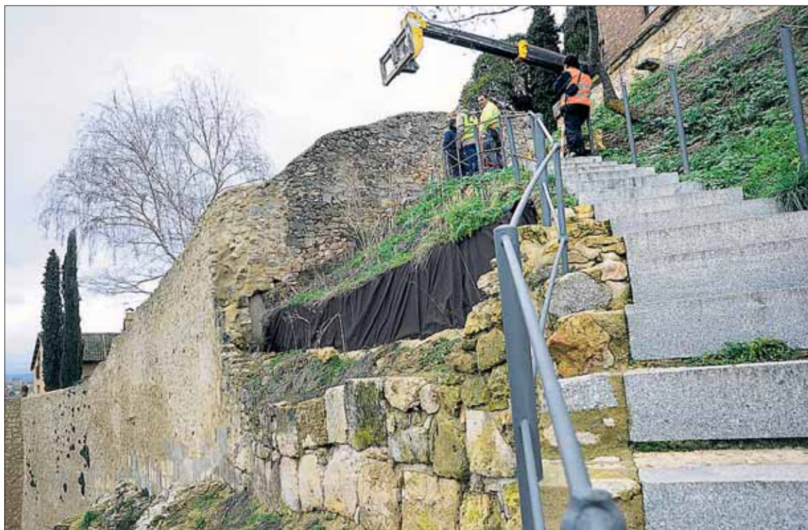
La Concejalía de Patrimonio Histórico prevé que las máquinas comiencen a trabajar esta misma semana. / KAMARERO
