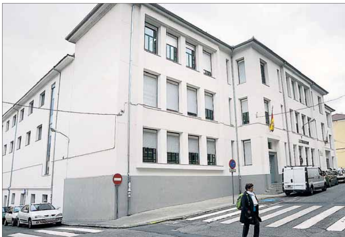
Fachada exterior del Colegio Villalpando, donde la caldera de calefacción y agua caliente ha tenido varias averías. / KAMARERO
