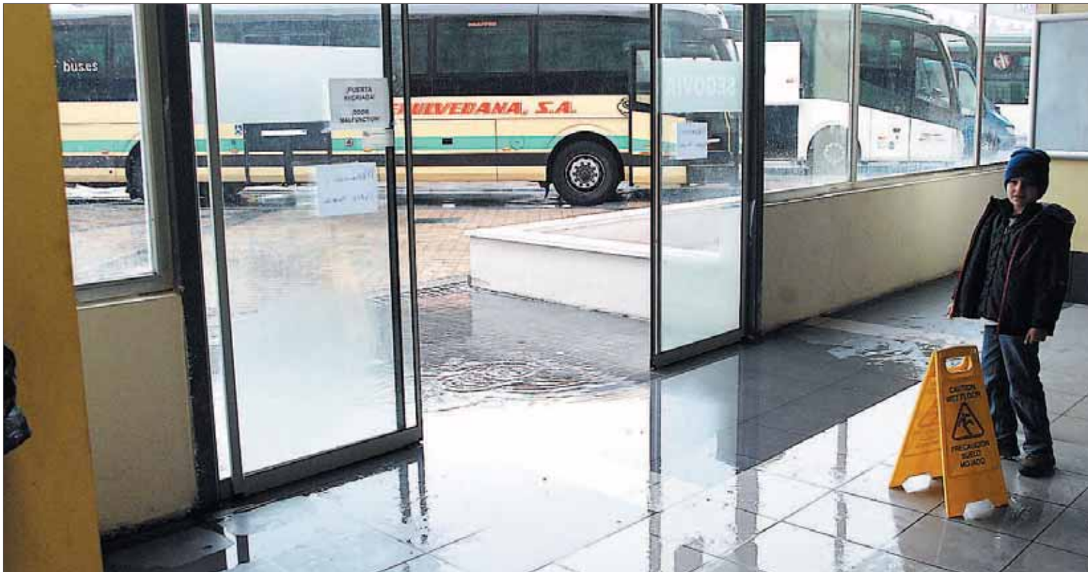
La balsa de agua que se formó a la entrada de la estación de autobuses no impidió el funcionamiento normal de la terminal, que no cerró sus puertas. / JUAN MARTÍN
