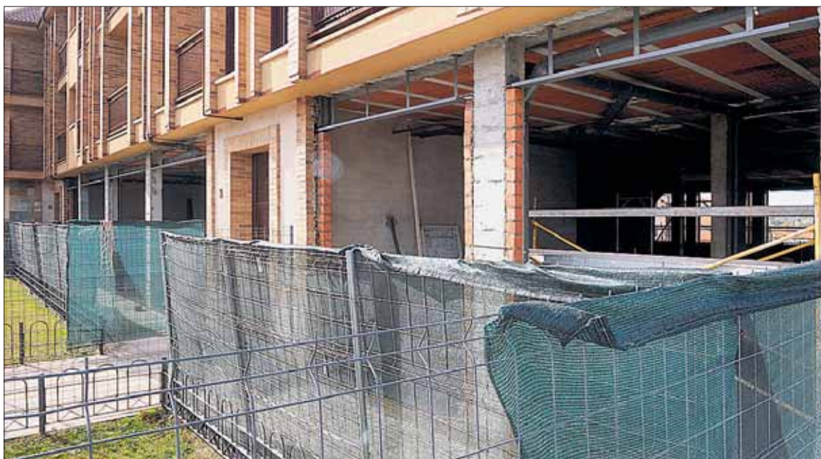
Las obras de la nueva Oficina de Empleo comenzaron en otoño de 2014, momento que muestra esta fotografía. / KAMARERO
